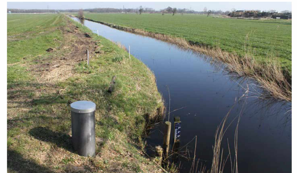
Afbeelding 7. De oostelijke hoofdwatgang met pijlbuis en net buiten de foto een stuw.
